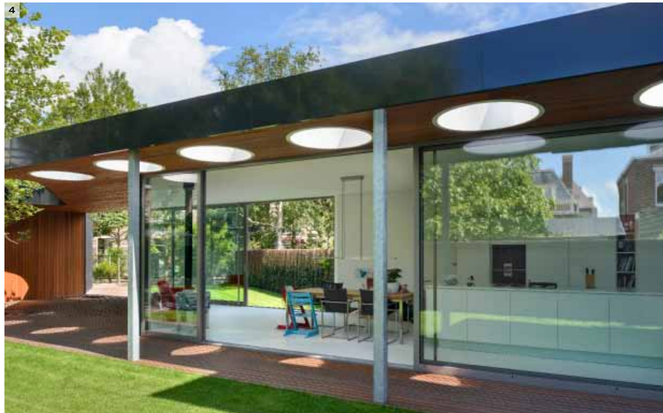
4 Sommerfreuden: 4 m breite Schiebetüren öffnen den Essbereich zu beiden Seiten hin zum Garten und schaffen so ein großzügiges Raumgefüge, das die Grenzen zwischen innen und außen aufzuheben scheint.
